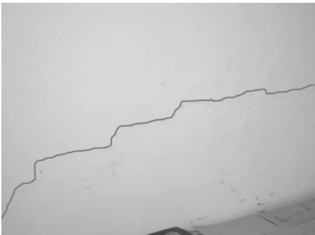
照片18 顶层东侧第二道横墙的阶梯型斜裂缝和水平裂缝
