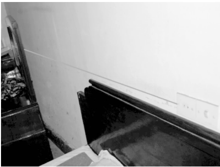
照片 3 底层⑬轴横墙的水平裂缝
