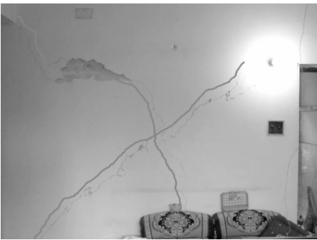
照片 13 供销社住宅楼第 2 层纵墙 X 形裂缝
