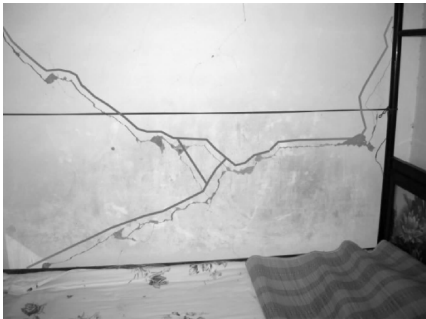
照片 1 底层⑥轴纵墙的 X 形裂缝
