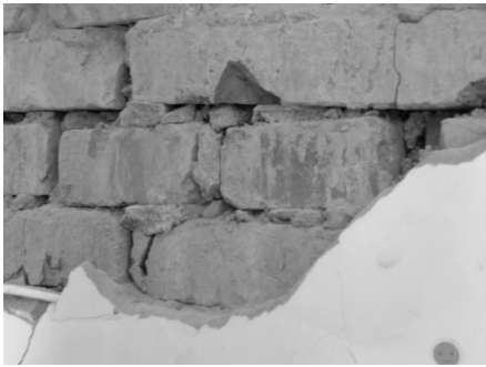
照片 4 砂浆灰缝不饱满
