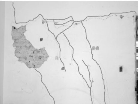
照片14 日杂公司住宅楼第2层Ⓑ轴内纵墙裂缝
