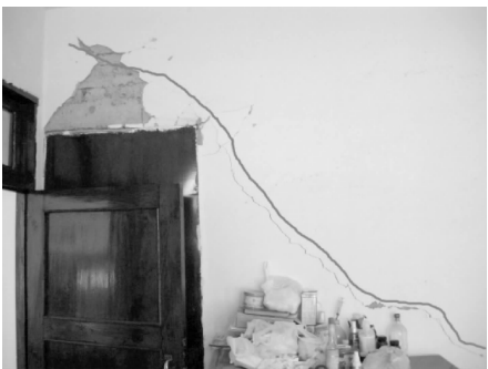
照片 12 供销社住宅楼第 2 层纵墙斜裂缝
