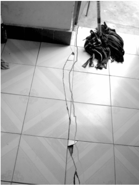
照片8 底层①单元地面裂缝
