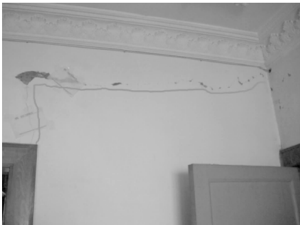
照片 6 圈梁下方水平裂缝
