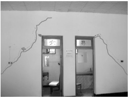
照片 11 供销社住宅楼底层抗震纵墙斜裂缝
