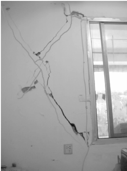
照片 2 底层①轴窗间纵墙的 X 形裂缝
