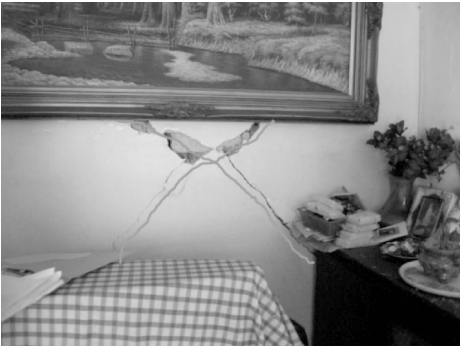
照片15 第2层Ⓑ轴内纵墙X形裂缝
