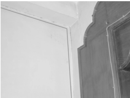
照片 7 纵横墙脱开裂缝
