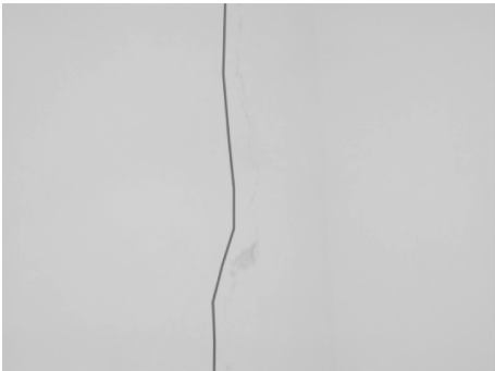
照片17 底层东侧山墙的竖向裂缝
