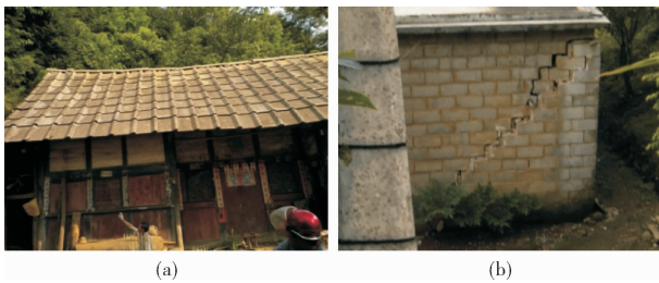
图 5 三甲绮结河郭家寨组滑坡体损坏的房屋(105.831°N, 26.764°E)
