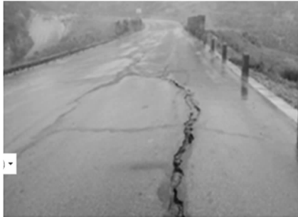
图 1 原路面破损严重
