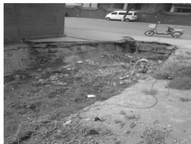
图2 S206 荣合路等公路水毁(路堤穿堤构筑物淤塞-漫流型)
