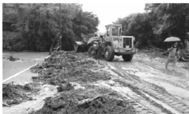
图 3 三教镇公路水毁抢险修复(弯道附属设施冲失型)
