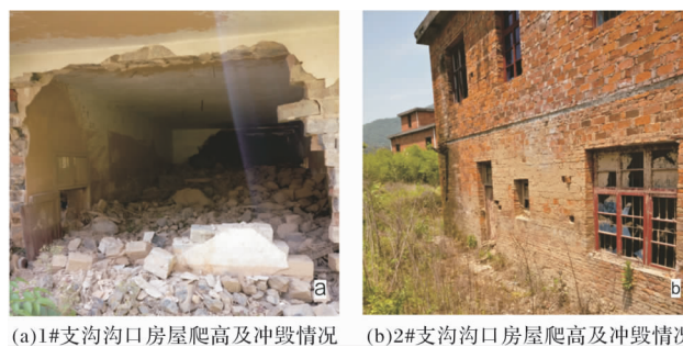
图6 泥石流的爬高及损毁情况
