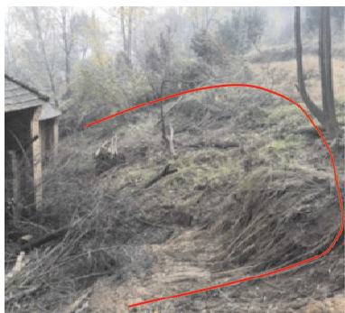
图 14 房后坡体局部滑动
