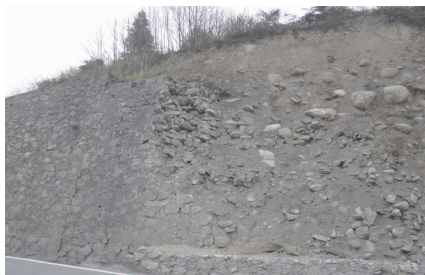
图 4 浆砌片石挡墙解体崩毁
