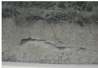
图 5 浆砌片石挡墙剪断
