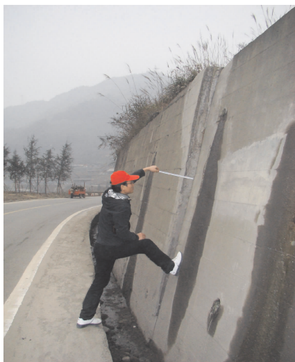
图 2 混凝土挡墙外倾
