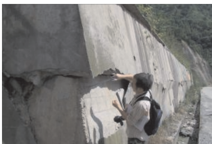
图 3 混凝土挡墙中部剪出
