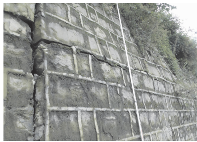
图 6 浆砌片石墙体凸出变形
