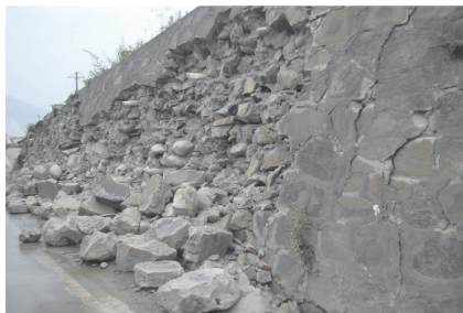
图 7 浆砌片石挡墙下部崩解
