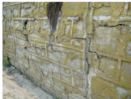
图10 浆砌片石挡墙鼓胀裂缝
