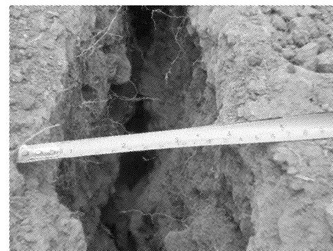
图 5 庆丰水库坝顶裂缝
