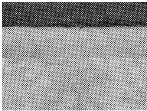
图 12 跃进水库上游防渗面板裂缝
