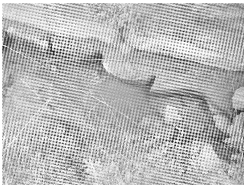
图 10 建兴水库下游坝脚出现管涌
