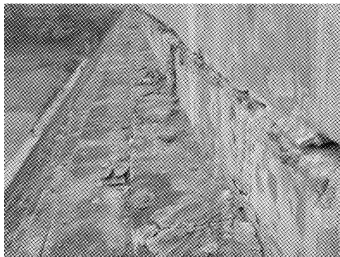
图 2 继光水库大坝下游面震裂情况
