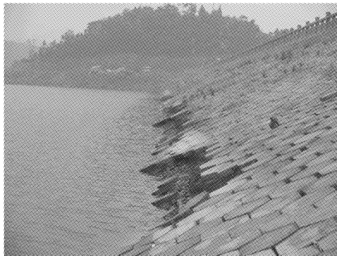
图 9 黄鹿水库迎水坡护坡滑移
