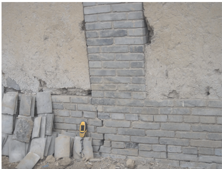
图3 汶川8.0级地震造成的房屋裂缝
