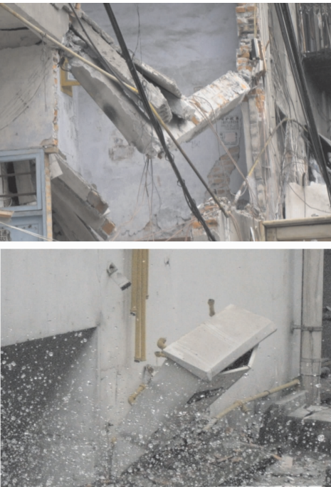
图4 低压配气支管和户外表箱的破坏
