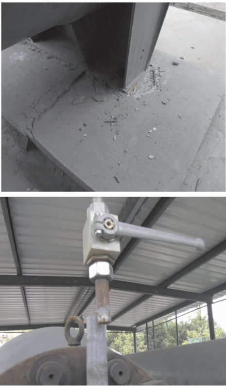
图3 储蓄罐和输气管的破坏
