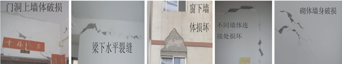
图2 汶川地震城市高层建筑部分典型墙体破坏情况
