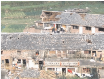
(b) 砖木结构房屋的小青瓦吹走侧墙倒塌
