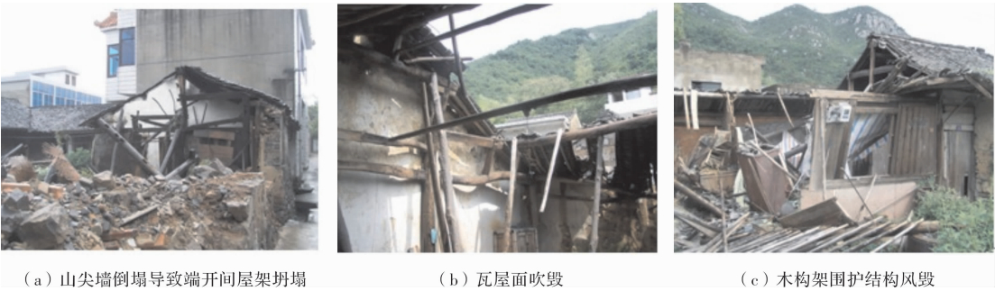
图3 象山县风灾中房屋的破坏形式
