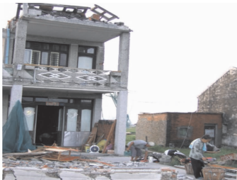
(c) 砖砌体结构房屋的屋面吹走侧墙倒塌
