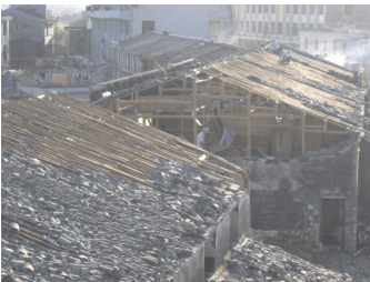
(a) 木结构房屋的屋面和墙壁被风吹走
