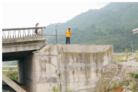
图7 桥梁右行错位 30 cm(镜向 NE)
