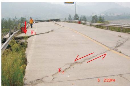
图4 引线段断裂形成断坎,护坡坍塌(镜向 NW)
