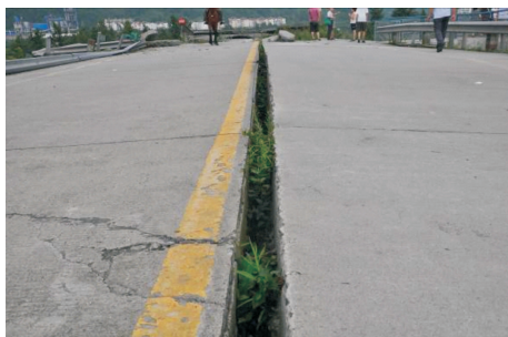
图6 路面纵向拉裂(镜向 NW)
