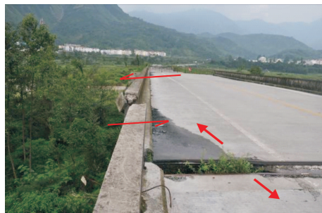
图8 伸缩缝拉裂并发生左行错动(镜向 NW)
