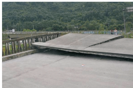
图9 桥台搭板飞落到桥面上并撞击护栏(镜向 SE)
