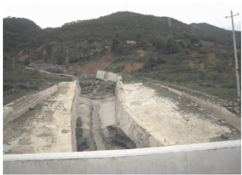
图 9 2011 年 6 月 16 日灾后排导槽内无淤积
