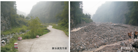
图 2 冷木沟中游泥石流发生前后沟道淤积变化对比特征 [9]
