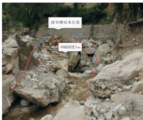
图6 泥石流冲毁排导槽
