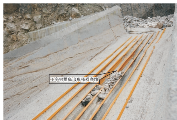
图1 地震灾区大比降排导槽磨蚀破坏
