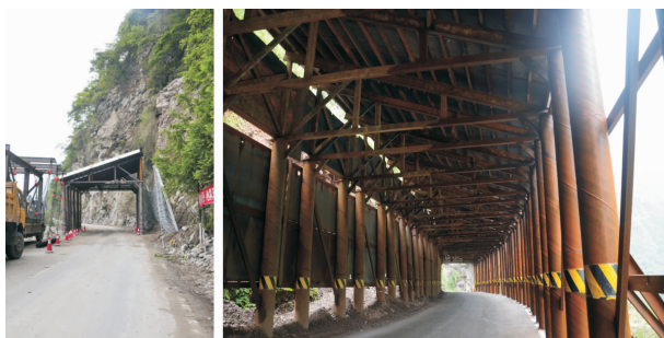
图 10 S210 线轻钢结构棚洞应急抢险工程
