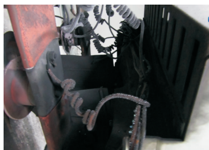
图3 雷击导致20号箱变原件损坏
