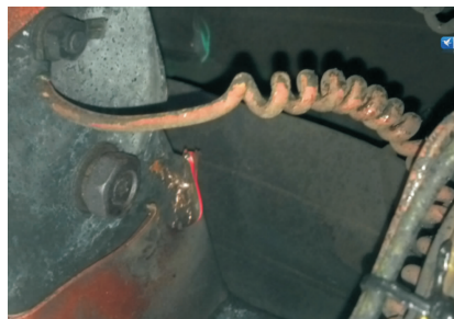
图2 雷击导致7号箱变损坏
