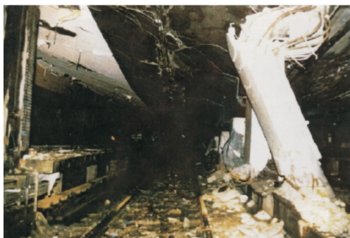
图7 地下结构的破坏情况
