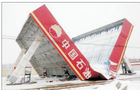
图1 南方地区被暴雪压塌的加油站 [5]
