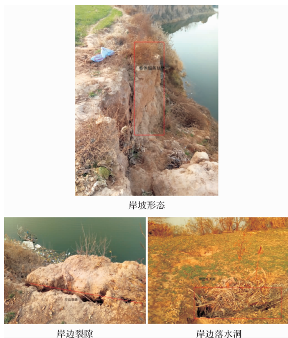
图2 淘蚀—塌落型边坡及破坏形态
