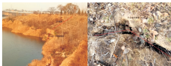
图1 简单削坡段破坏形态
