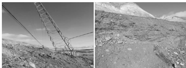
(a) 电力铁塔被下滑边坡土体冲斜 (b) 路基滑塌后断面土层情况
