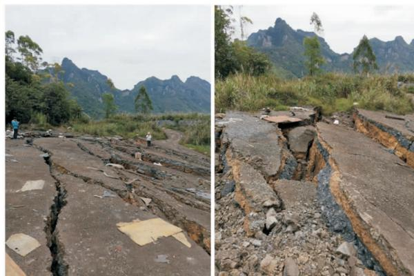
图2 广西靖西5.2级地震造成地裂缝
