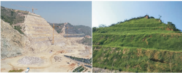
图 11 韩城西山露天开采岩面开发式治理复绿效果
