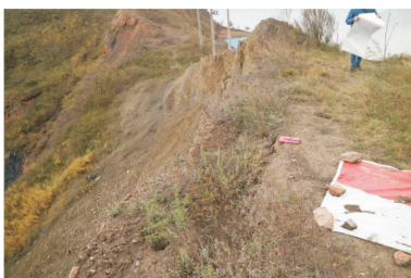
图 8 滑坡后缘错落
