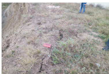
图 7 左侧后壁缘边发育的裂缝
