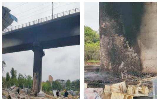
图1 火灾灾害后混凝土结构
