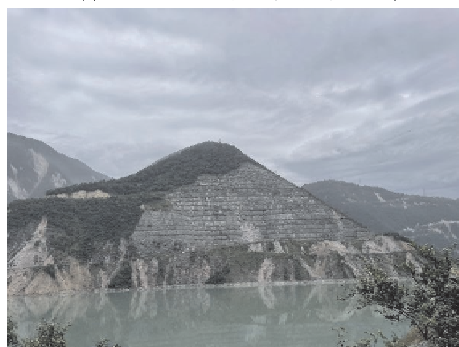
(b) 库区梭子头附件锚喷支护边坡(镜向: 63^{\circ} )
